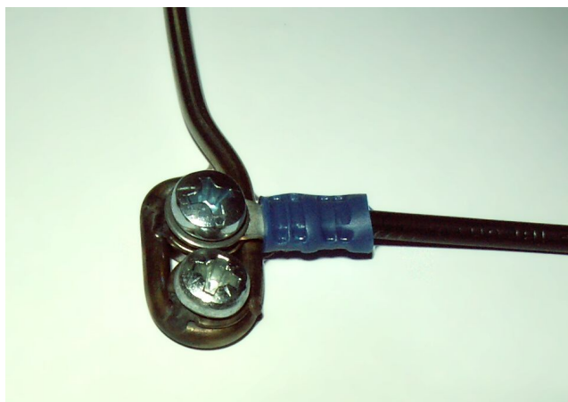
Obr.1 - Detail ukotvení držáku na stěnu a napojení napájecího kabelu. 1-es kép: A tartó horgonyának részlete a falon és a tápkábel csatlakozása. Rysunek 1 - Szczegóły wspornika kotwicy na ścianie i podłączyć przewód zasilający.
