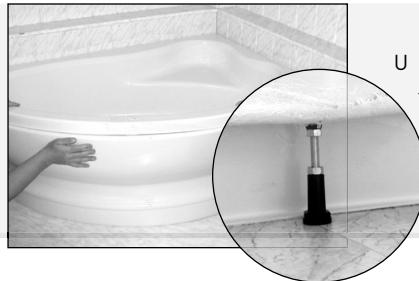
U krycího panelu u vany JÁVA nejdříve instalujte opěrnou ožičku do místa zalamínované matice M 12 - viz. detail
