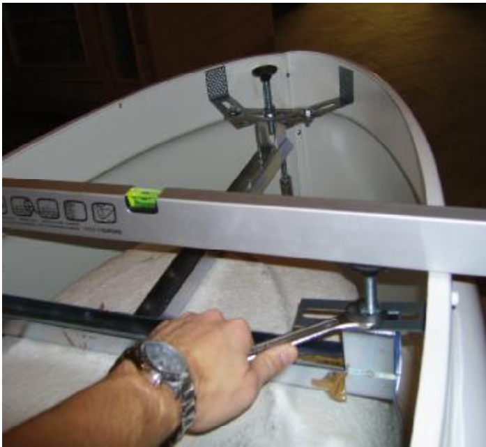
nožičky seřídít do roviny dle vodováhy
